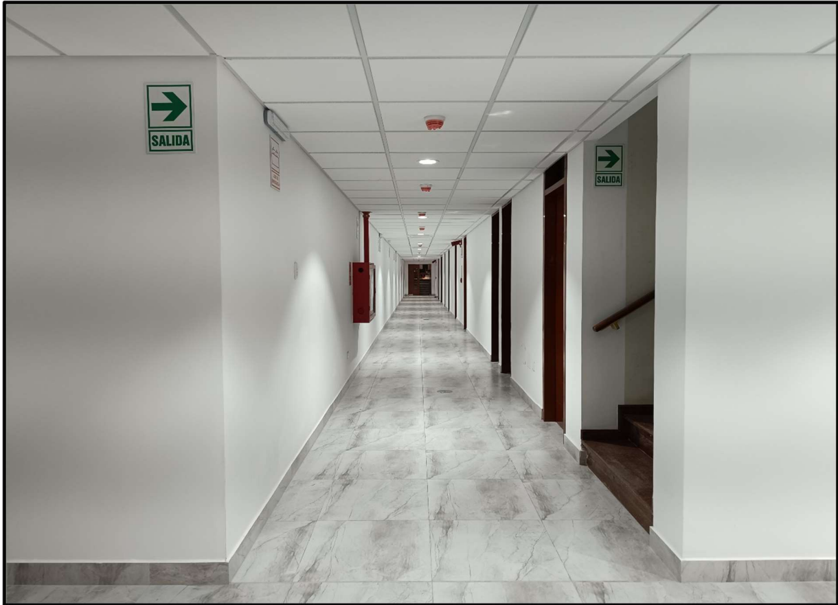
Foto 01: Vista final corredor técnico N° 01
