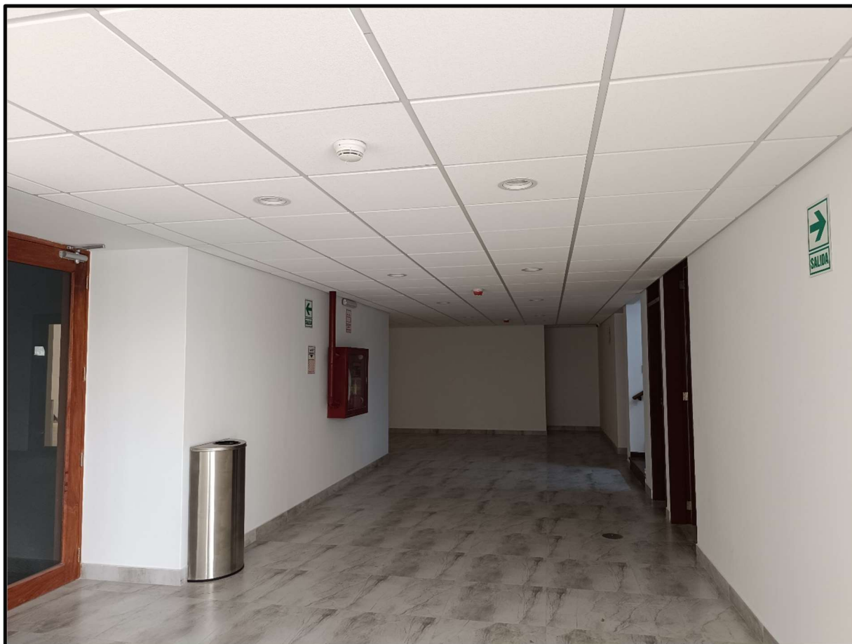
Foto 19: Vista Baldosas finales en corredor, eje D
