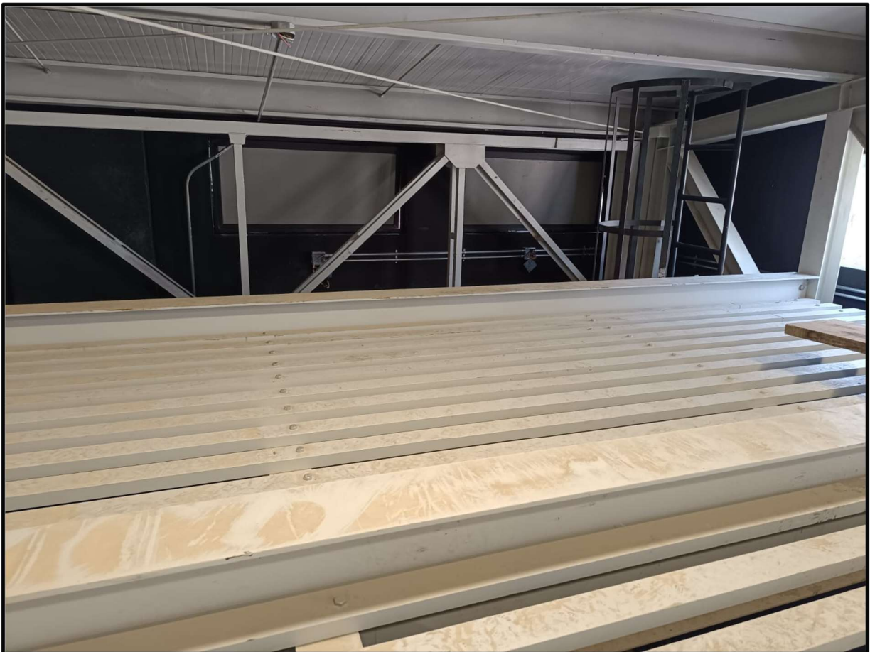
Foto 38: Estructura peine escénico y vista interior de exhutorios
