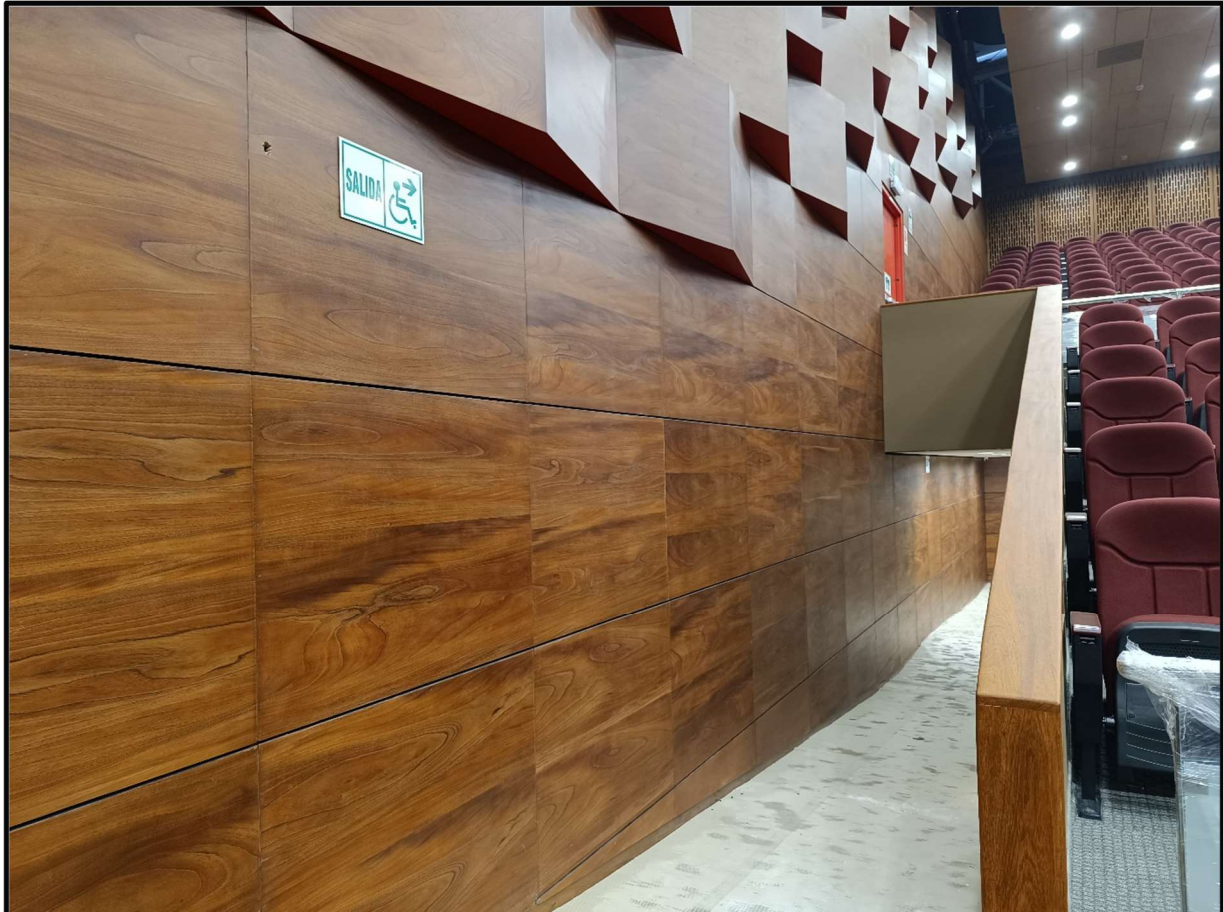
Foto 46: Luces y acabados en rampas de acceso, lado eje B
