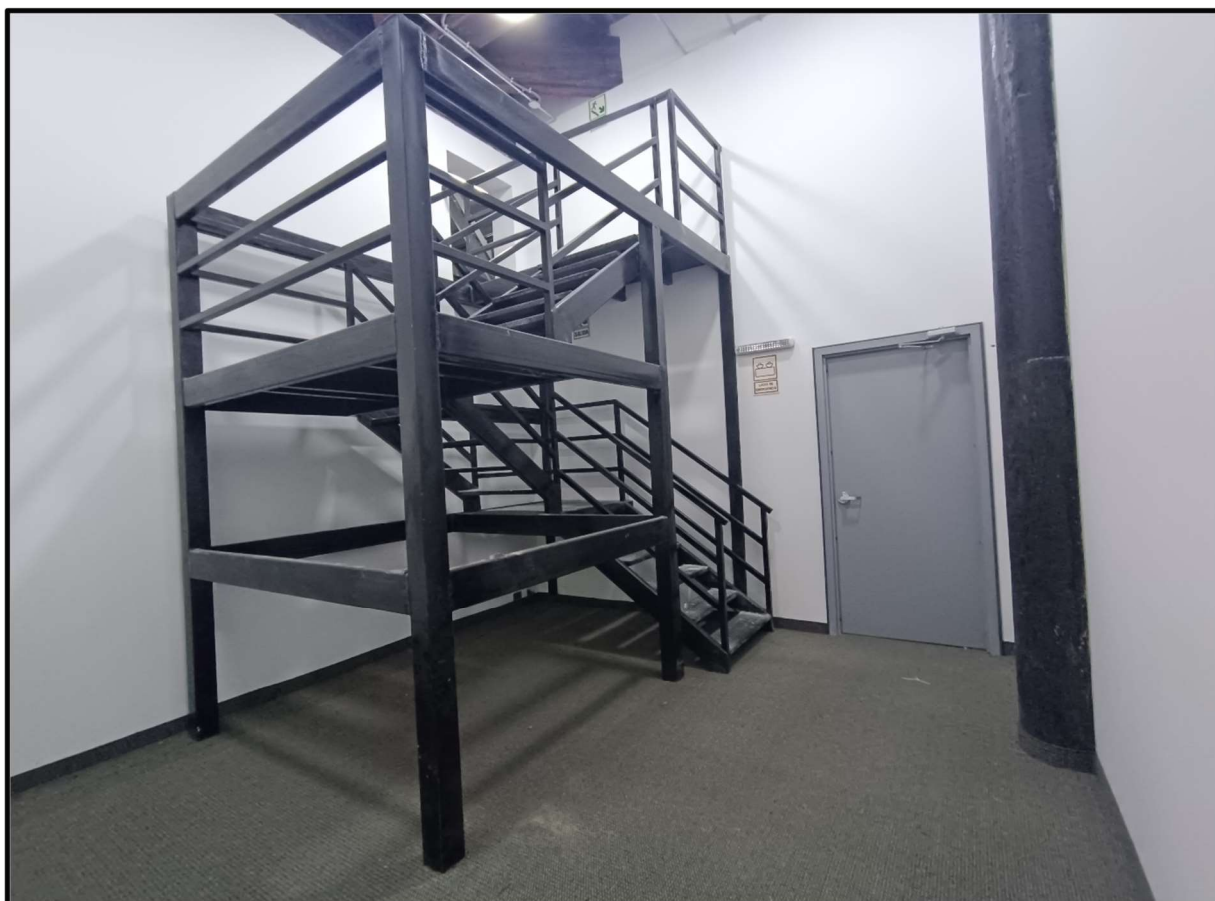
Foto 32: Escalera metálica en cabina de control hacia pasarela
