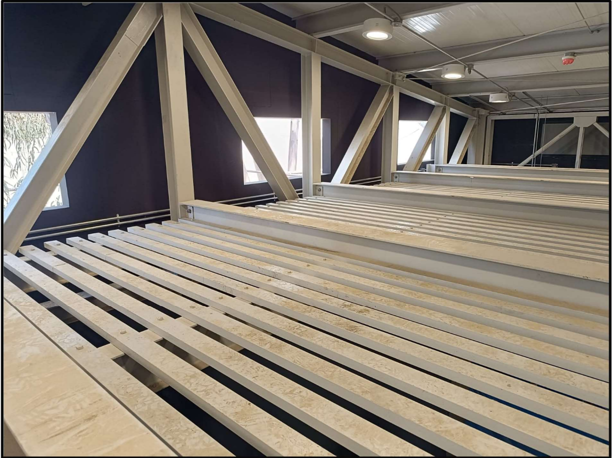
Foto 37: Estructura peine escénico y vista interior de exhutorios
