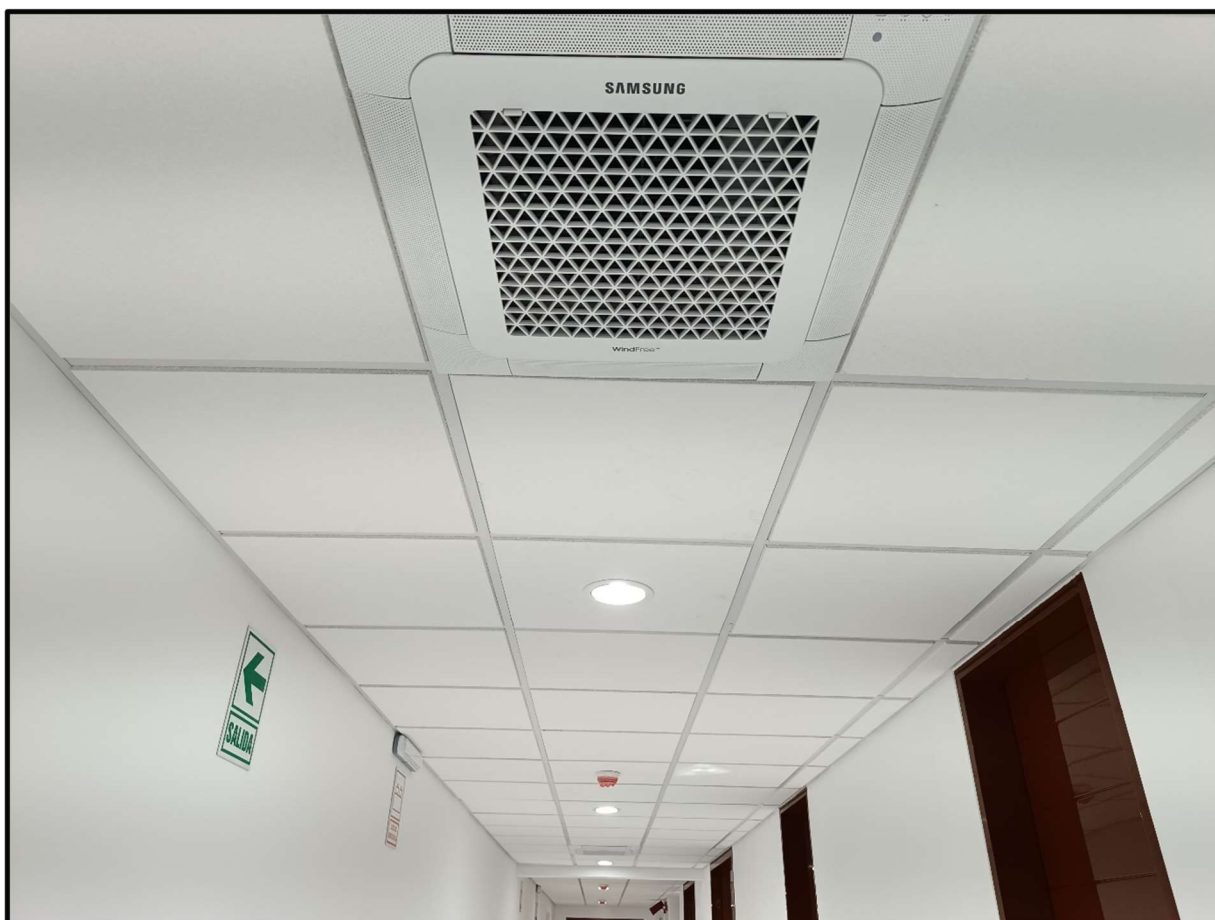
Foto 20: Vista Baldosas finales en corredor técnico 01, eje B
