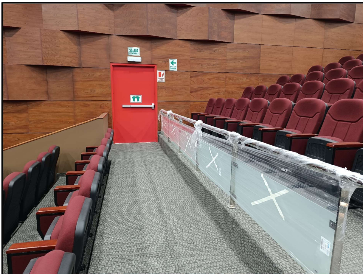
Foto 47: Puerta corta fuego y señalizaciones en escenario, lado medio escenario
