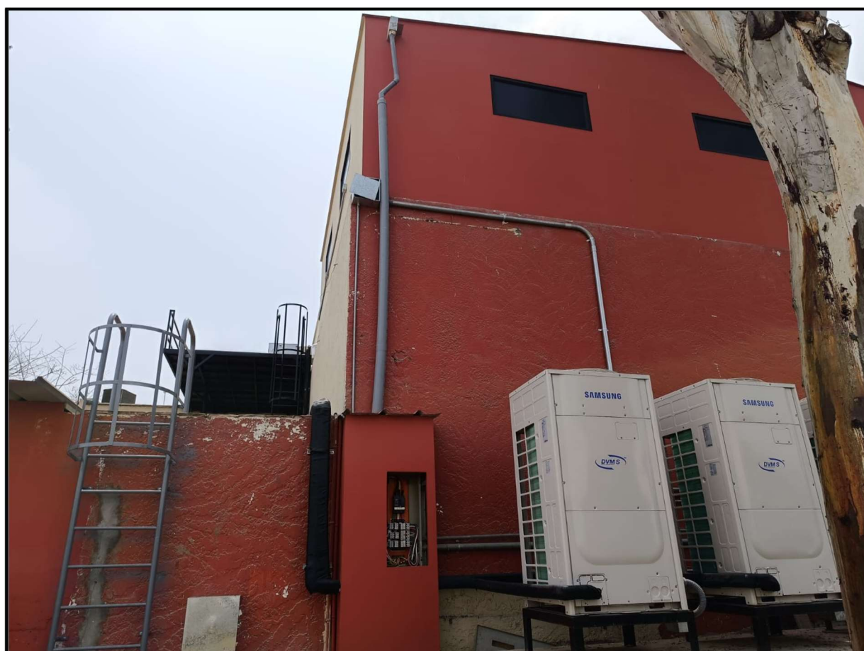
Foto 42: Escalera de gato reubicada.
