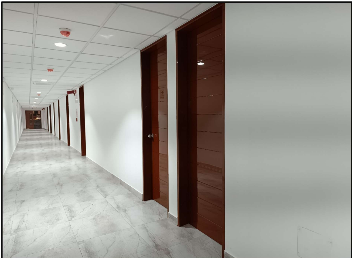
Foto 02: Acabados finales de puertas en corredor VALORIZACIÓN MENSUAL DE OBRA N° 10 – SETIEMBRE 2024
