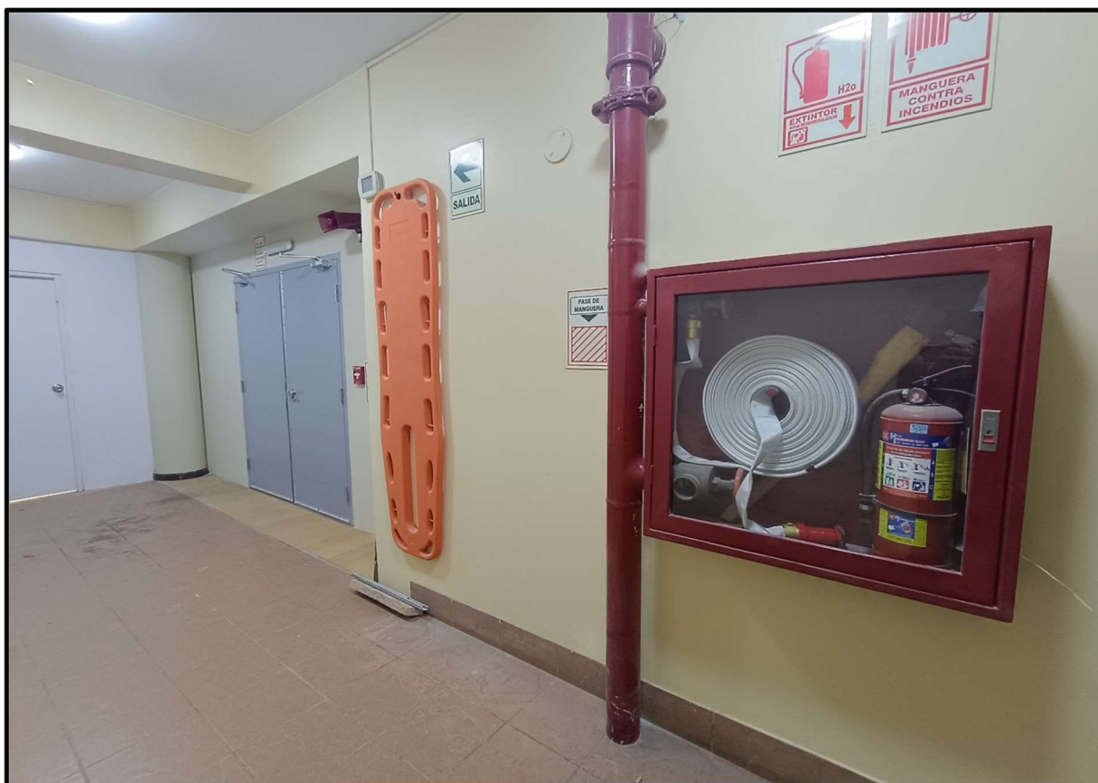
Foto 25: Gabinete contra incendio en corredor 03 y señalizaciones
